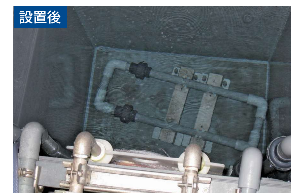
※配管洗浄から1ヶ月後
