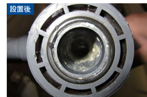
※配管洗浄から1ヶ月後
