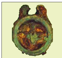
腐食した鑄鉄バルブのジスク
