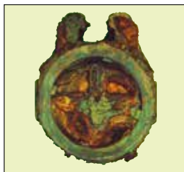
腐食した鑄鉄バルブのジスク
