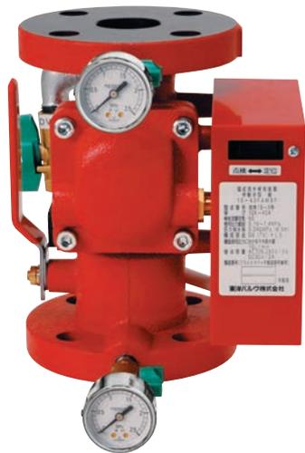
火災発生時、スプリンクラーの作動放水により、警報やポンプ起動電気信号を発信する「流水検知装置」（通称:アラーム弁）です。
