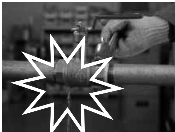
接合部分よりの水漏れ
