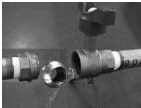
ボールの脱落
