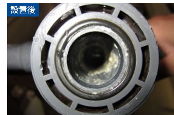
※配管洗浄から1か月後
