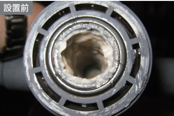
※配管洗浄から1週間後
