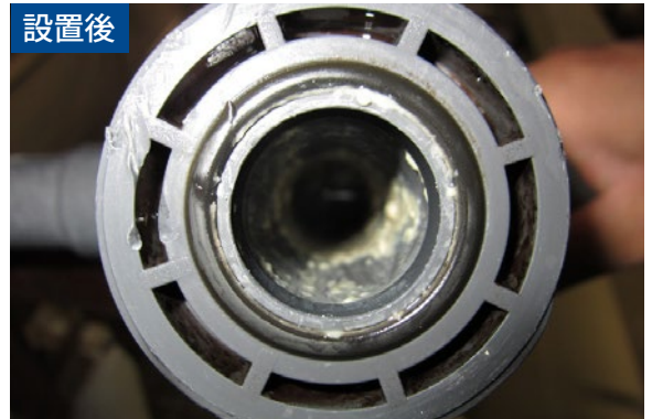
※配管洗浄から1か月後
