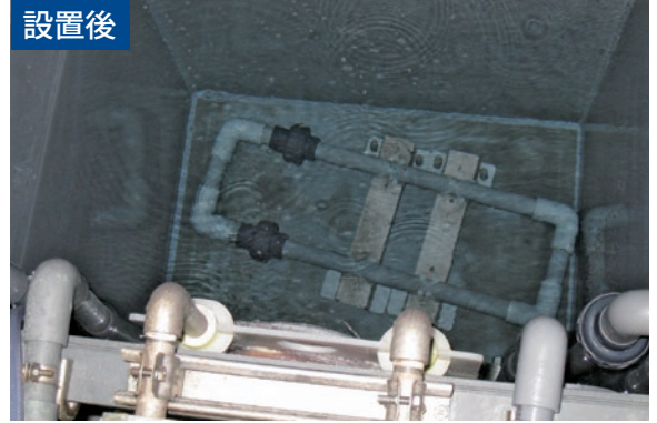
※配管洗浄から1か月後
