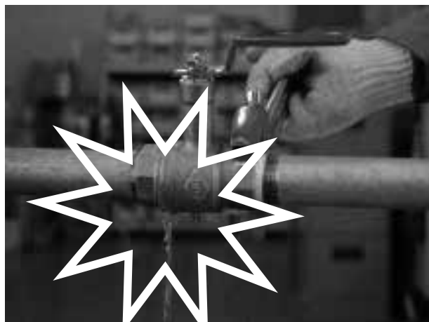
接合部分よりの水漏れ
