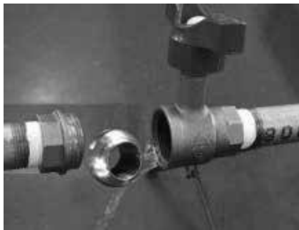
ボールの脱落
